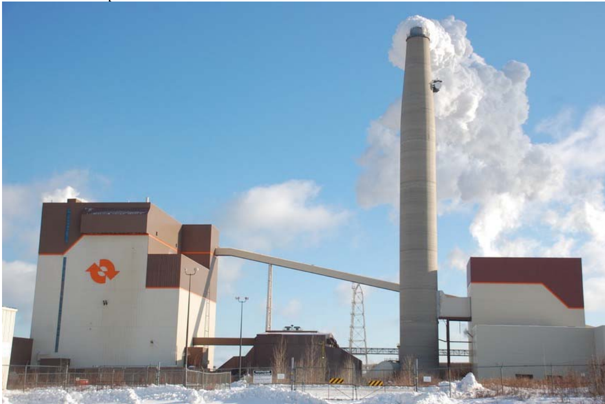
Centrale électrique de Belledune
