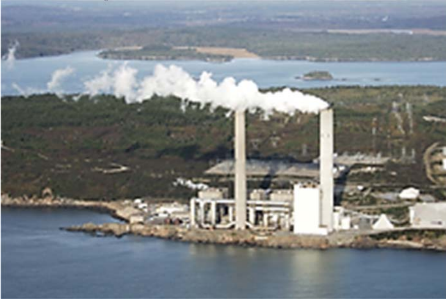
Centrale électrique de Coleson Cove
