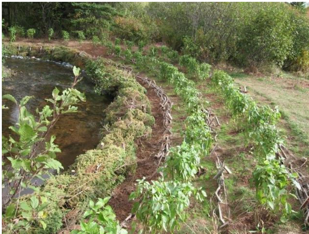
Stabilisation des berges par la végétation naturelle et plantée à la main
