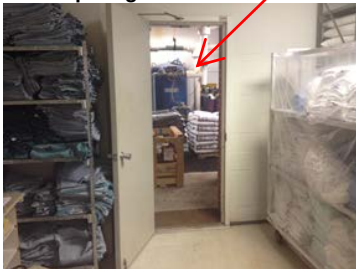
✗ Emplacement inadéquat pour le stockage de linge propre : le personnel d'entretien doit traverser chaque jour la salle de linge propre pour avoir accès à leur lieu d'entreposage
